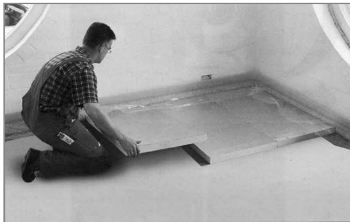
Укладка изоляции PUR
