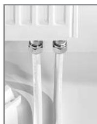
Подключение радиатора с использованием направляющего уголка
