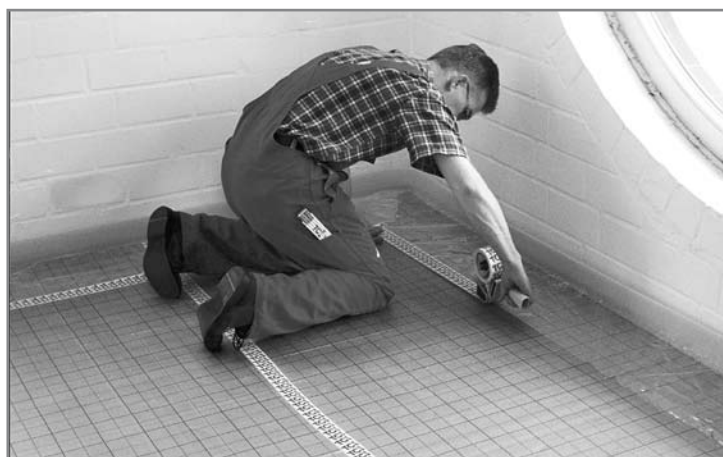
Уплотнение краевых изоляционных полос
