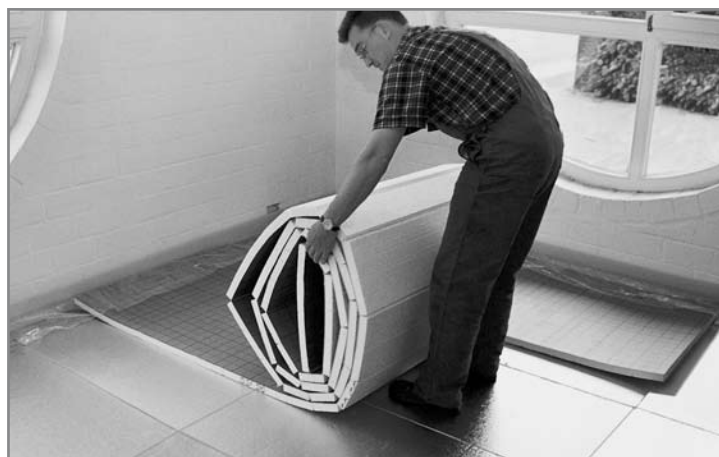
Укладка рулонной изоляции
