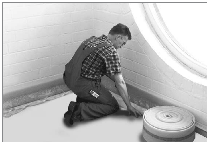
Укладка демпферной ленты
