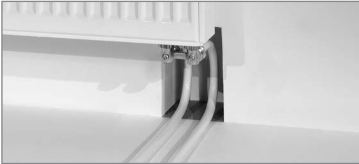
Подключение радиатора из стены
