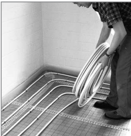
Укладка трубопровода
