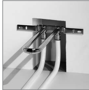
Подключение с использованием монтажной планки без установки радиатора
