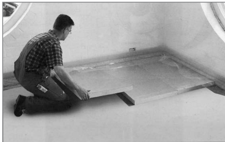
Укладка изоляции PUR
