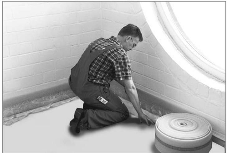
Укладка демпферной ленты
