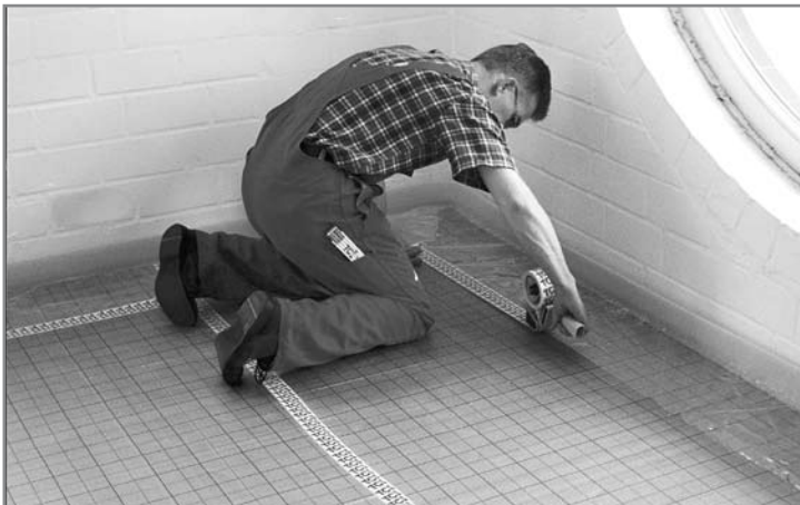
Уплотнение краевых изоляционных полос
