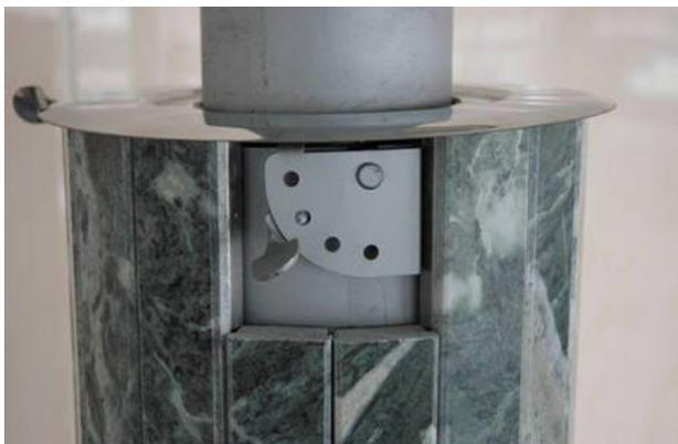
для печей Ламель Optima: наверху дымоходных труб «конвектор» и «экономайзер» есть крышка ограничения конвекции. Ее открывают при растопке и закрывают после того, как парная готова.
